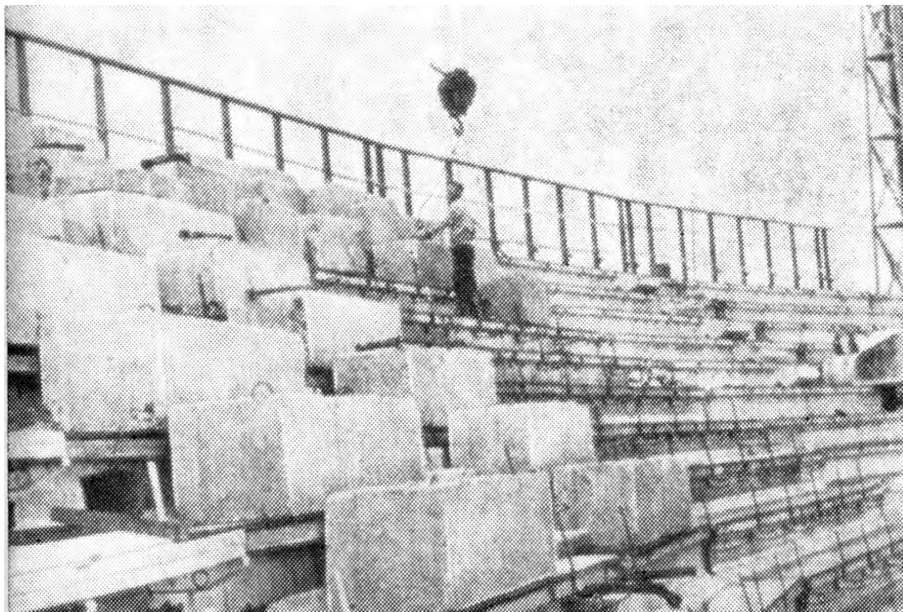
Рис. 34. Испытания гидроизоляции на водонепроницаемость под нагрузкой (Центральный стадион в Киеве).
